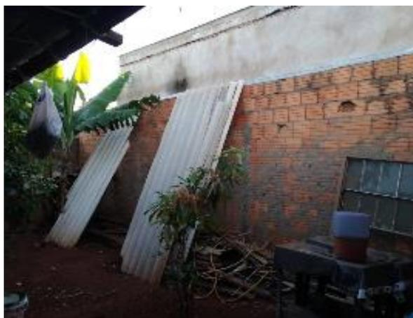
Figura 24 - Estocagem inapropriada de materiais construtivos
