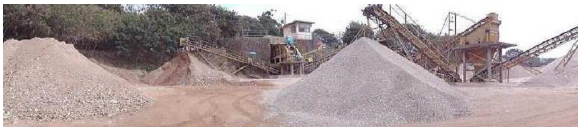
Figura 1 - Pátio de operação e armazenamento da AR da BR-040
