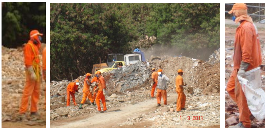
Figura 2 - Proteção individual dos trabalhadores nas ARs
