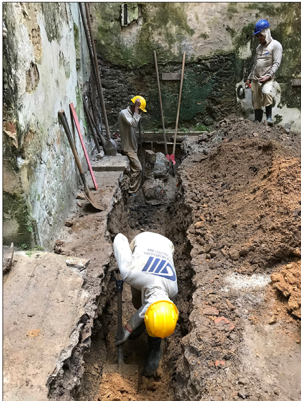
Figura 4. Escavação de uma trincheira dentro do sítio. Foto: Ney Gomes (2019).
