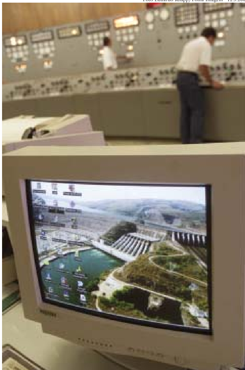
Sala de Controle da Usina Hidrelétrica de Furnas (MG).
