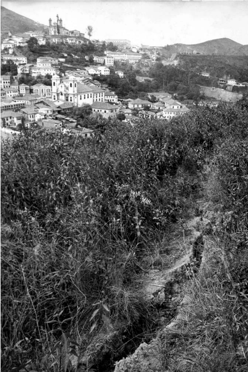
Figura 1 - Detalhe de fenda observada na encosta à montante da Rua Dr. Horlando Ramos (Fonte: IPHAN).
