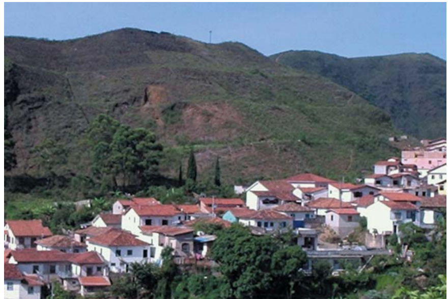
Figura 2 - Residências próximas da encosta, Vila São José; observar o escorregamento na área do retaludamento.
