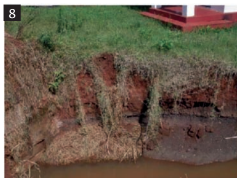
Figura 8 Talude erodido.
