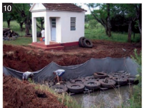
Figura 10 Muro em execução.
