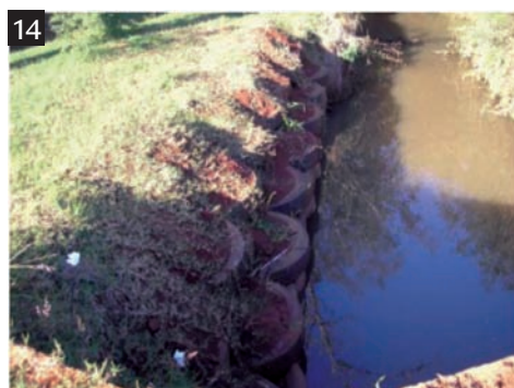
Figura 14 Estrutura em março 2007.
