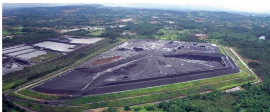
Figura 3 Vista superior do Módulo B de rejeitos da UM II - Criciúma S.A (centro) e as bacias de sedimentação utilizadas no tratamento da água de processo (esquerda).
