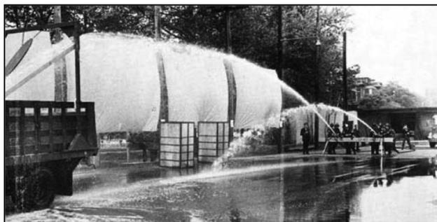
**Figura 1.** Ensaio realizado pelos bombeiros de Nova York, no final da década de 60, para demonstrar o potencial do efeito de redução de atrito hidrodinâmico. Uma bomba impulsiona água por uma das mangueiras e água contendo 30 ppm de poli(óxido de etileno) por outra. Reproduzida da ref. 5, com permissão da Elsevier
