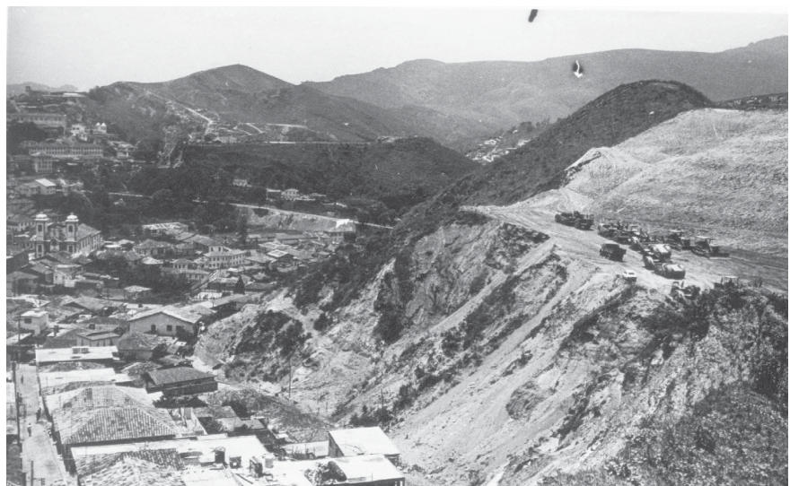
Figura 3 - Obras de retaludamento na encosta Vila São José (1980). Fonte: IPHAN.
