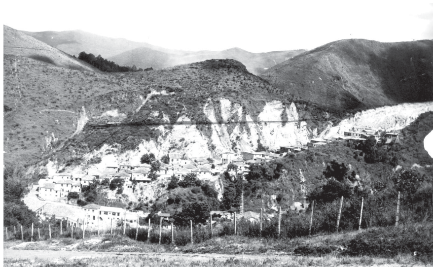
Figura 2 - Movimento de massa ocorrido em 1979. Fonte: IPHAN.
