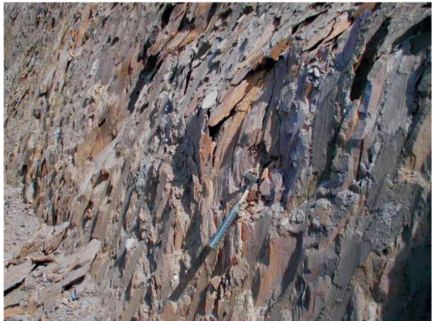
Figura 1 - Ruptura por flambagem em talude da Cava Cachorro Bravo.
