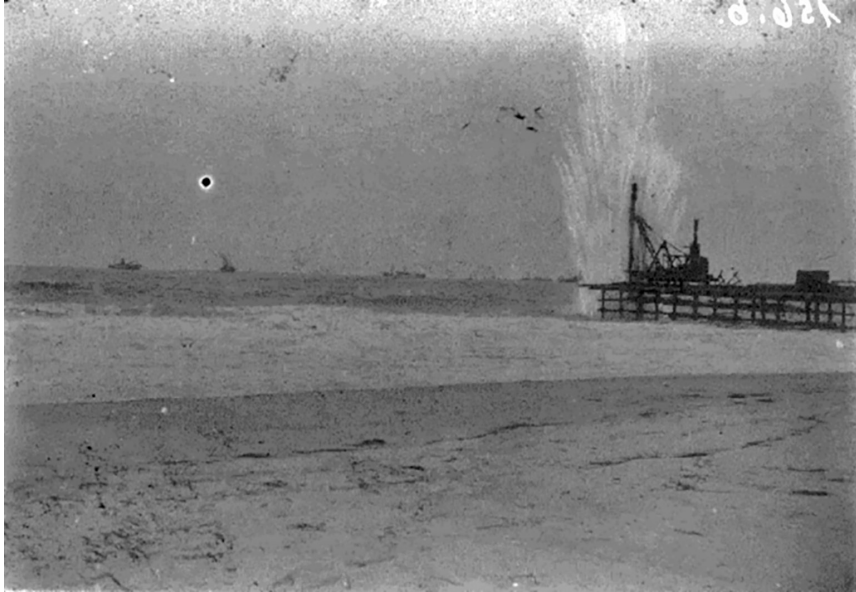
Figura 14 Explosão na construção do pier de Swakopmund, África do Sudoeste Alemã
