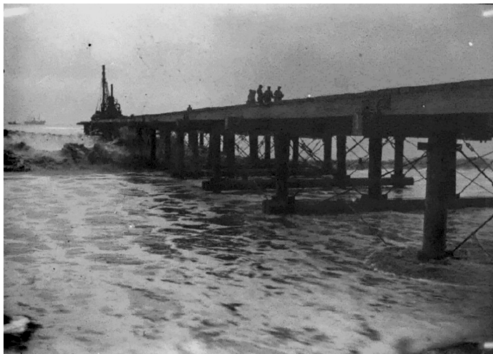
Figura 16 Pier reconstruído, Swakopmund, África do Sudoeste Alemã
