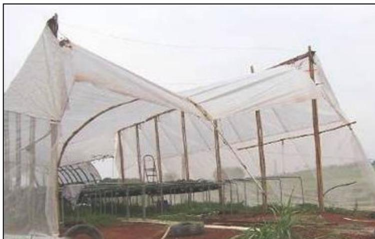
FIGURA 10. Vista da estrutura tipo tenda construída com bambu, após a fixação do plástico de cobertura.
