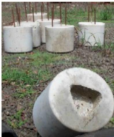
FIGURA 6. Base de concreto para fixação (encaixe) das colunas.
