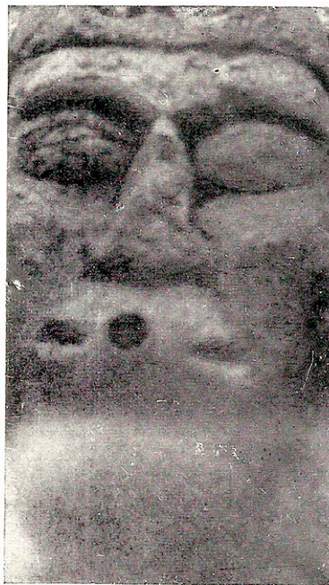
Chafariz de Marília. Estado de ruína duma das carrancas.
