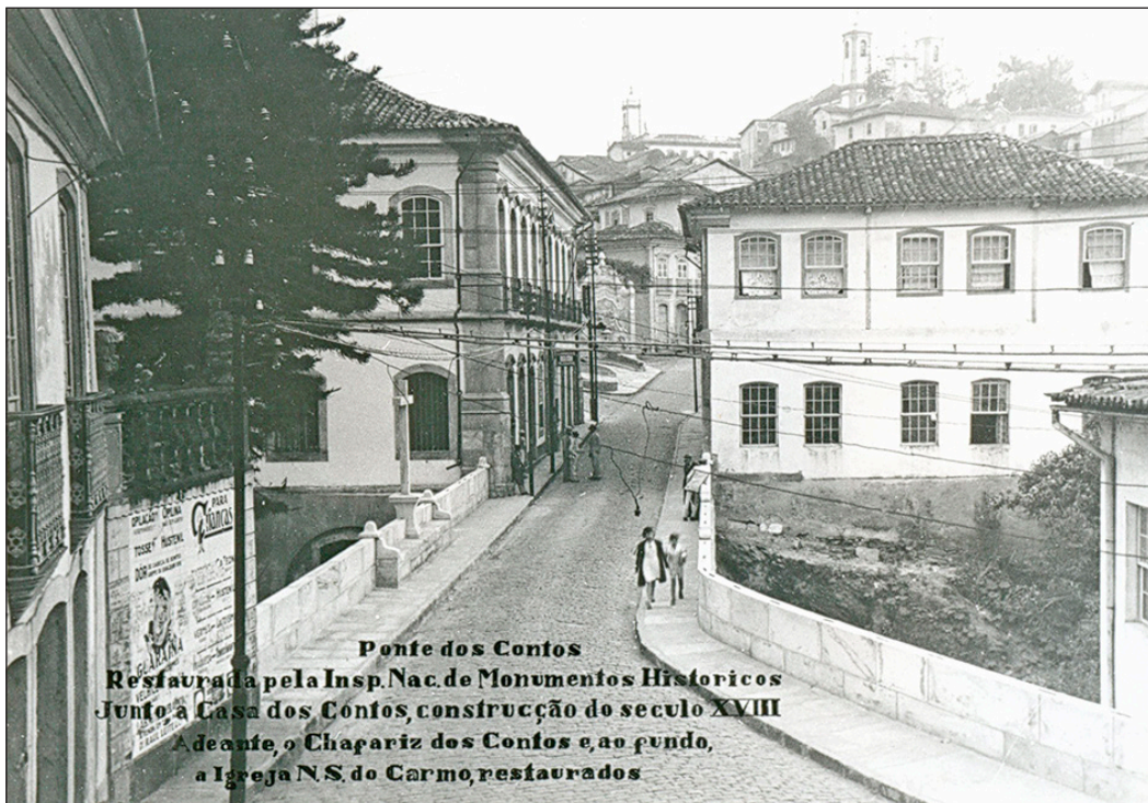
Figura 12 – Ponte dos Contos após intervenções da IMN. Fotografia de Luiz Fontana. Acervo do Arquivo Central do IPHAN, Seção Rio de Janeiro.
