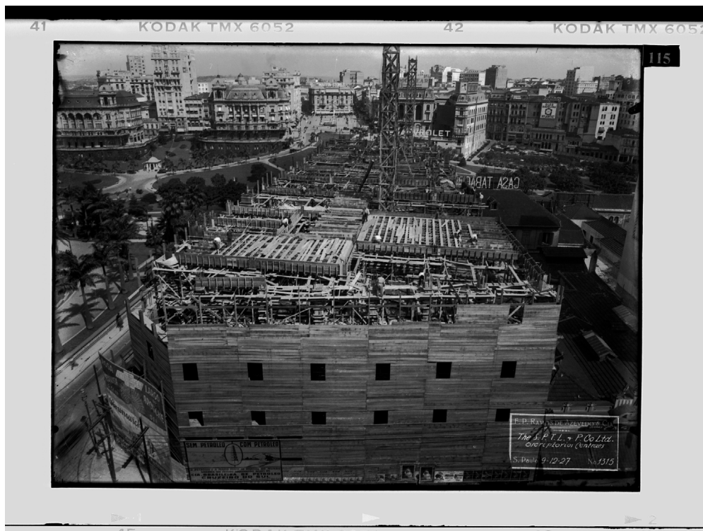
Figura 5 – Imagem do canteiro de obras do edifício Alexandre Mackenzie, atual Shopping Light, São Paulo (1927-1928). Fonte: Acervo Ramos de Azevedo, Seção Técnica de Materiais Iconográficos da Biblioteca da FAU-USP.
