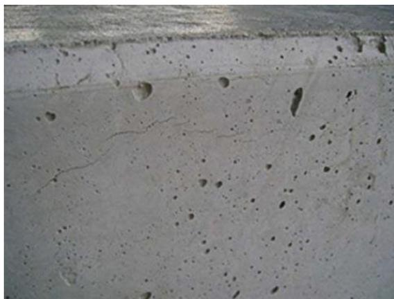
**Figura 4:** Bolhas na superfície do elemento de concreto (Fonte: MILANI *et al.*, 2012 [7]).
