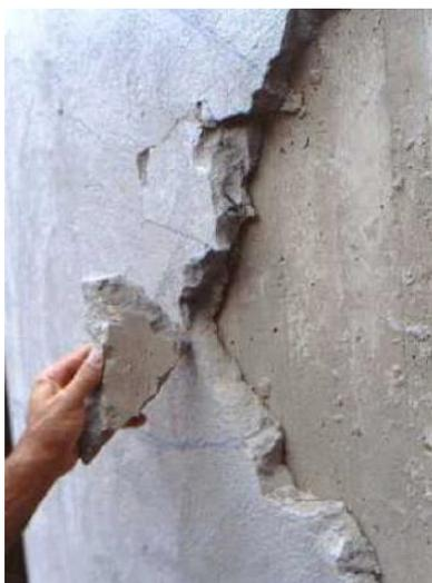
**Figura 5:** Descolamento de placas coesas com ruptura na interface chapisco/substrato (Fonte: CARASEK; CASCUDO; JUCA, 2005 [13]).
