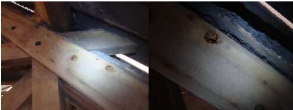
Figura 5 - Cavilhas degradadas
