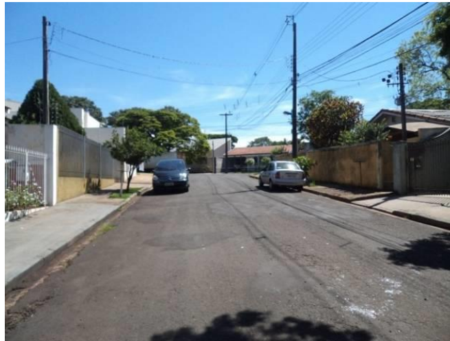
Figura 8 - Lacunas na Rua Agnel Canno - Zona 5
