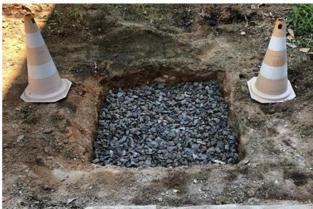
Figura 9 - Sistema simulador de drenagem concluído
