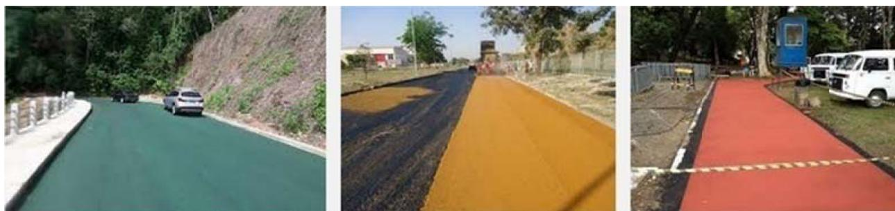
**Figura 1:** Fotos de asfalto colorido. (Fonte: <http://www.brasilengenharia.com/porta/construcao/1525-a-craft-engenharia-desenvolve-asfalto-colorido>)
