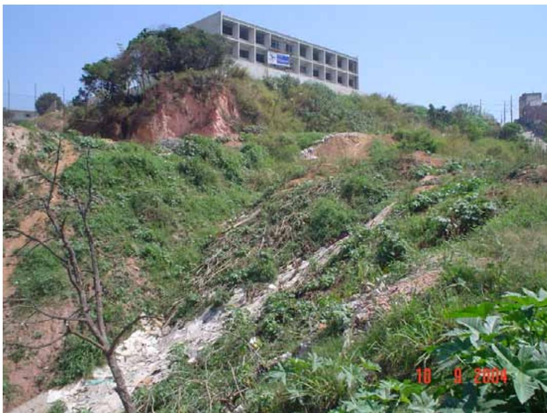
Figura 3 - Aspecto geral da Cava do Jardim Britânia, em 2004. Taludes expostos à ação das intempéries e grande quantidade de material irregularmente depositado. A antiga superfície do terreno foi soterrada.
