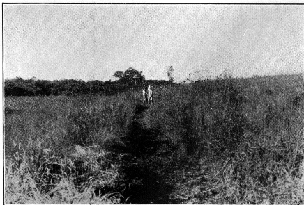
Fig. 14 — Limpando o local por onde passará o canal adutor, o qual seguirá contornando a encosta.
