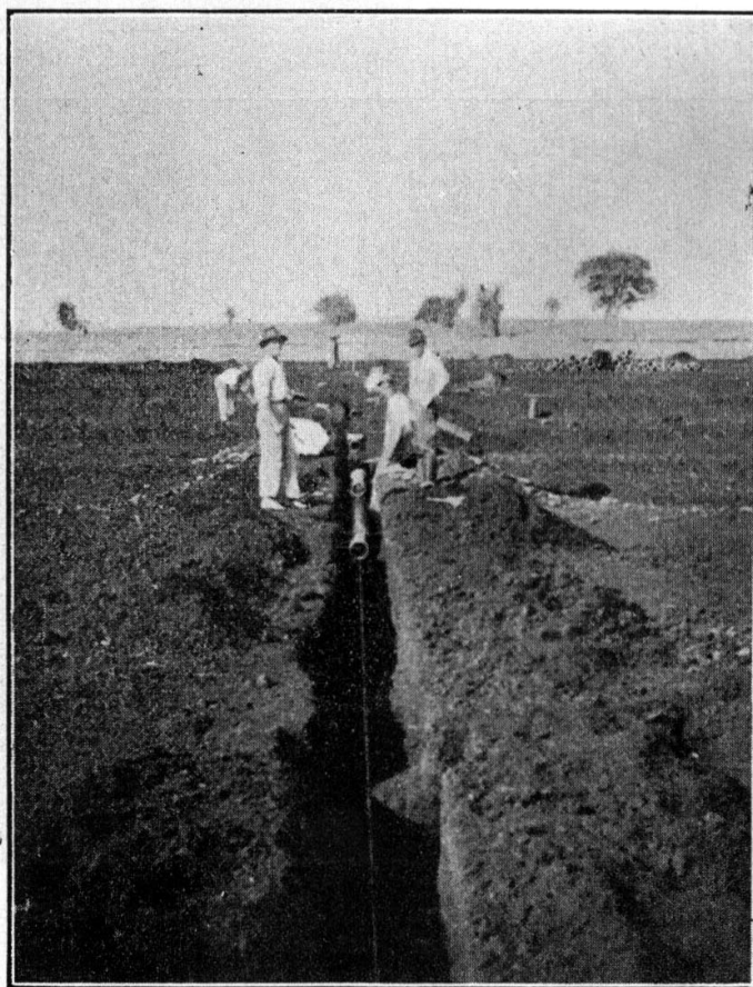
Fig. 10 — Construção de um dos condutos distribuidores durante a instalação das manilhas.
