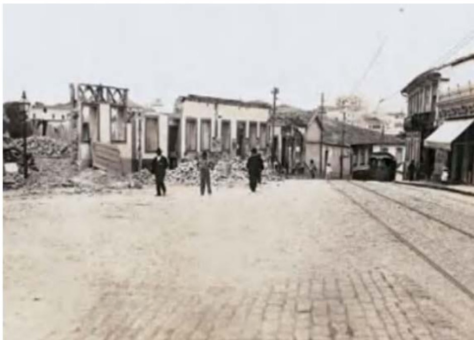
Figura 7 - “Demolição de casas, à esquerda, para construção do viaduto Santa Efigênia”. Fonte: Oliveira (2011, p. 97).
