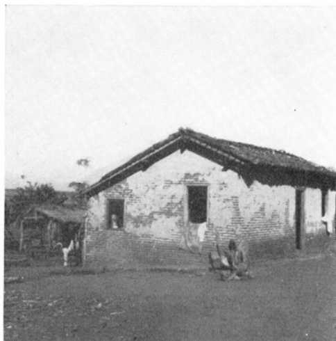
Fig. 10 — Casa do Bairro João Pedro, mostrando a construção de tijolos não revestidos.
