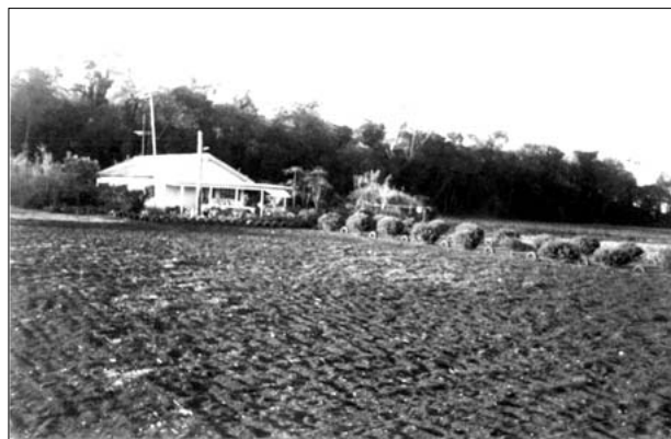
Figura 5 - Residência localizada na zona rural da região norte do Estado do Paraná, Brasil.
