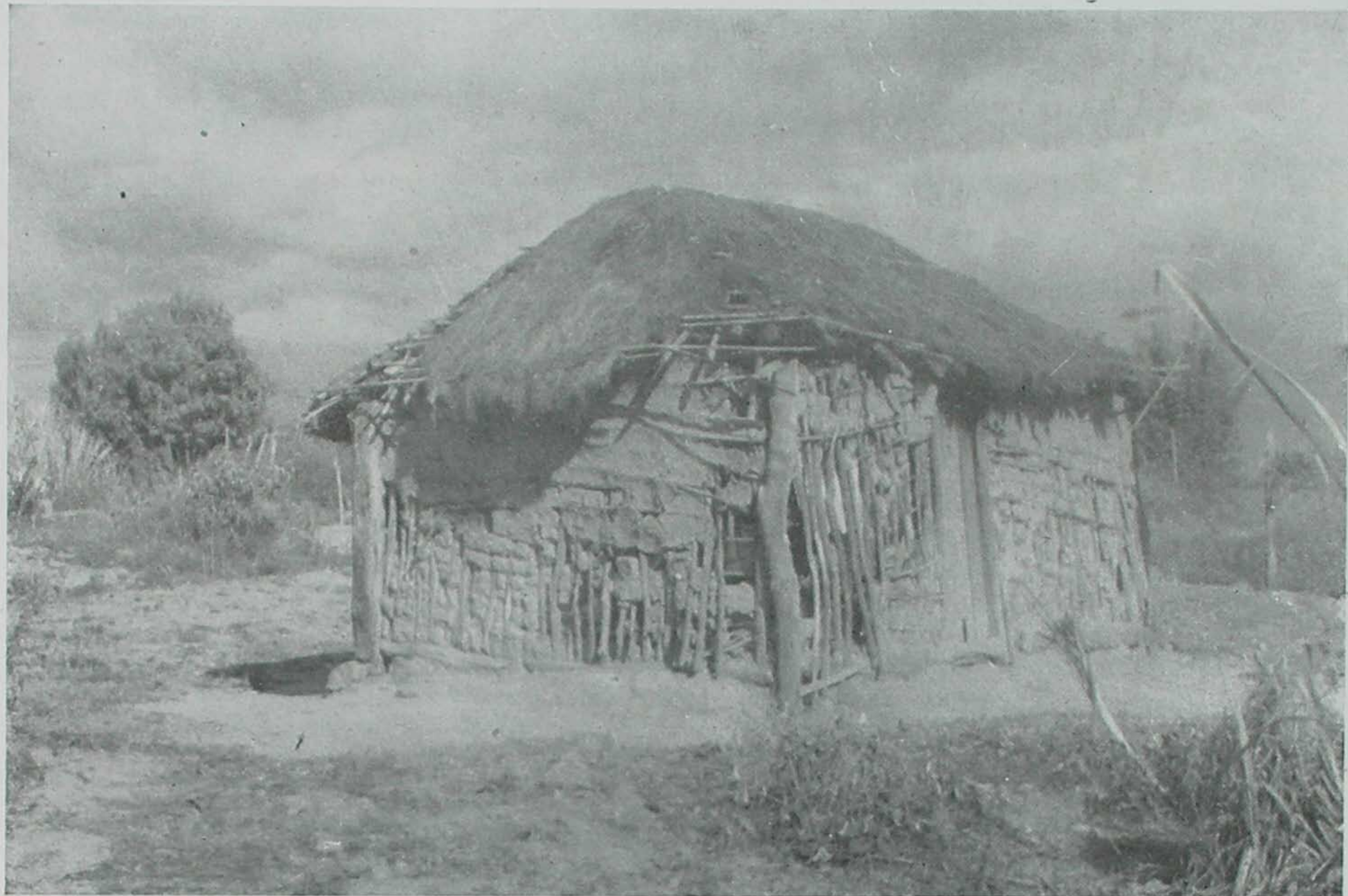
Fig. 2 — Exemplo de habitação de pau a pique coberta de capim (cafú). Grande infestação por triatomas e vários casos de esquizotripanose. (Seg. E. Dias, 80).
