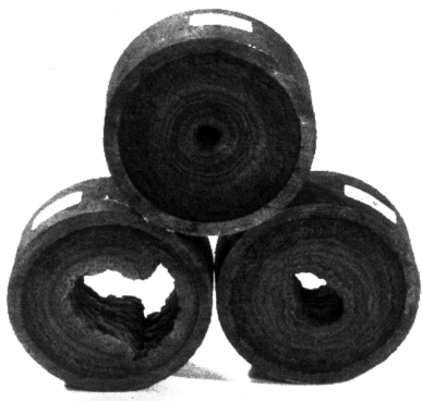
Figura 1a. Fotografia de testemunhos de tubulações usadas na exploração marítima de petróleo, já em estado avançado de incrustação.
