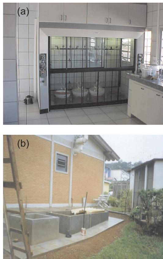
**Figura 5.** Laboratório de Resíduos Químicos após modernização: (a) sistema de destilação e (b) caixas de tratamento de água
