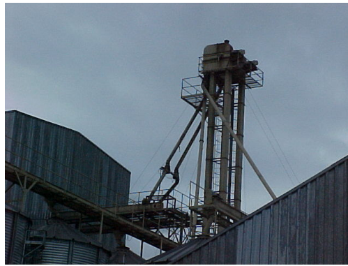
FIGURA 8. Vista parcial do sistema de movimentação de grãos.
