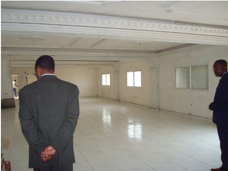
Imagem 03: tabernáculo tokoista em construção, Luanda, 2007. Foto: Ruy Blanes.
