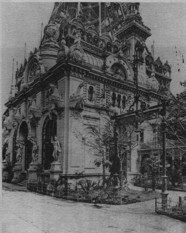
Figura 12. Pavilhão do Brasil, ângulo formado pela fachada (à esquerda) e a lateral da qual se projetava a galeria aberta (à direita). Atrás do Pavilhão, a Torre Eiffel. Fotografia de Glück, extraída do Album de l'Exposition 1889 , prancha 18. Acervo Biblioteca Nacional.
