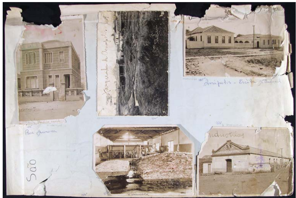
Figura 10 – As fotografias e o suporte do Álbum do Interior Goiano, em avançado estágio de deterioração. Acervo do Museu da Imagem e do Som de Goiás, Goiânia. Fotografia de Richam Samir, 2005.
