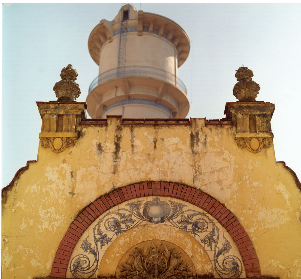
Figura 12 – Detalhe do pórtico do Biotério, ao fundo a caixa d’água. Fotografia de Roberto Jesus Oscar e Vinícius Pequeno de Souza, 2003. Acervo do Departamento de Arquivo e Documentação/ Casa de Oswaldo Cruz, Fundação Oswaldo Cruz (Fiocruz), Rio de Janeiro.
