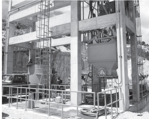
Figura 1. Vista do elevador para peixes da Usina Hidrelétrica Santa Clara. À direita pode ser observada a caçamba em elevação e à esquerda o caminhão-tanque usado para transporte.
