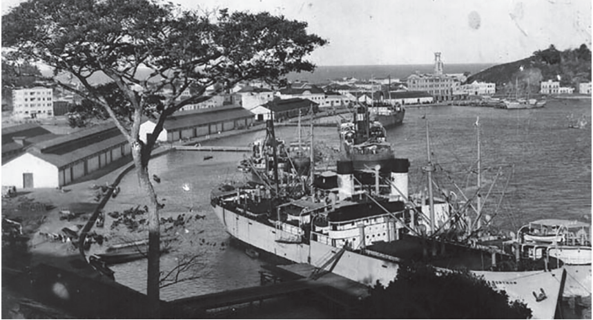
Figura 2: Vista do porto de Ilhéus.
