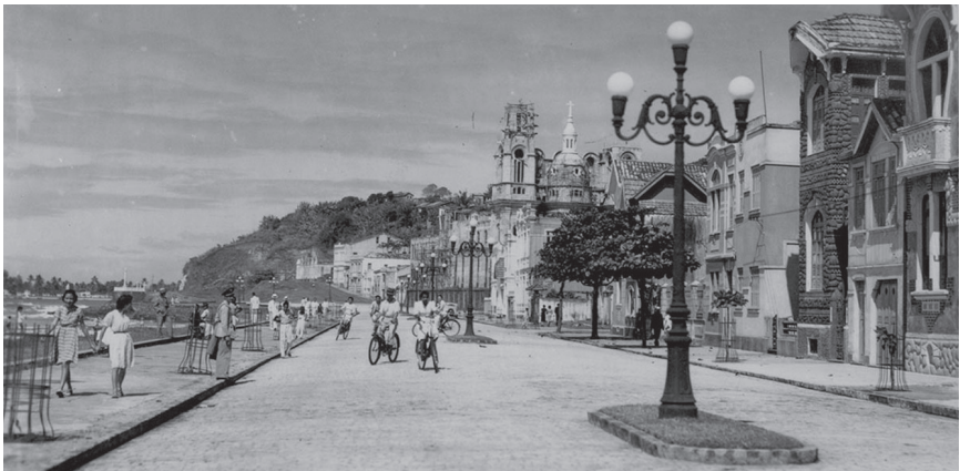
Figura 3: Vista da avenida Beira-Mar.
