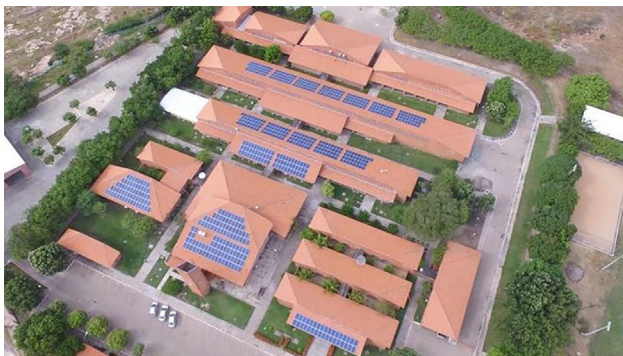
Figura 1 - Sistema fotovoltaico instalado sobre o telhado do campus Floriano do IFPI. Fonte: IFPI, 2019.
