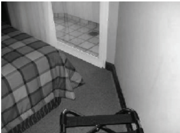
Figura 7: Vão de acesso à sacada – quarto da UH A.
