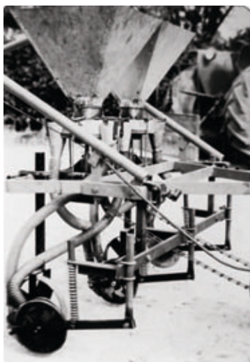
Figura 4. Protótipo da semeadora adubadora construído pelo IAC, acoplado ao chassi porta-implementos.
