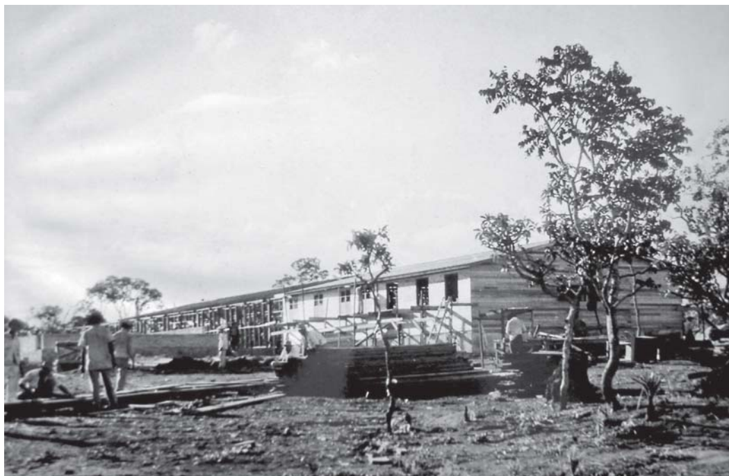
Figura 3: Hospital Juscelino Kubitschek de Oliveira em construção, abril de 1957 (Arquivo pessoal de Edson Porto).
