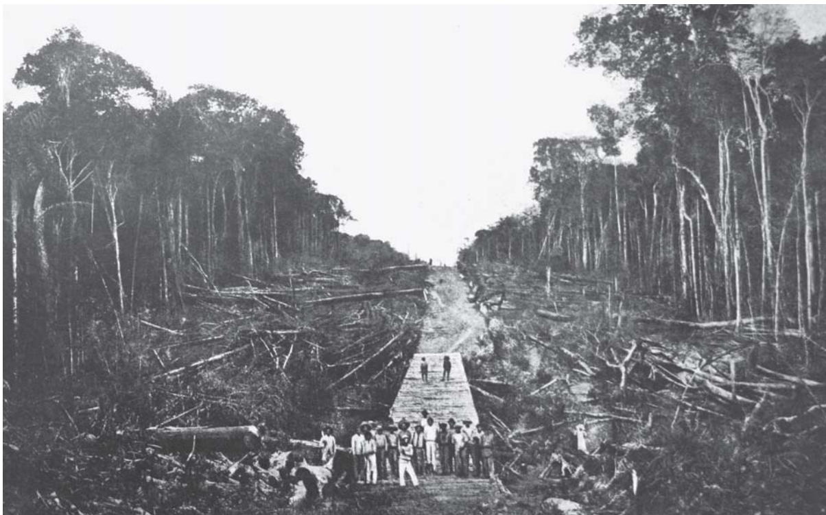
Figure 3: "Trecho do picadão através da mata, vendo-se ao centro a faixa destocada para estrada de rodagem" (Stretch of right-of-way through the woods, with center section graded for the roadway; Rondon, s.d.-b, estampa 30).
