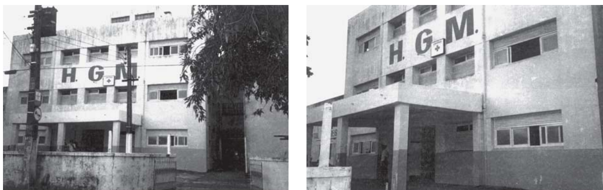
Figura 3: Hospital Gomes Maranhão, Recife (PE), construído em 1958. 1997 (Acervo pessoal de Marcia Monteiro)
