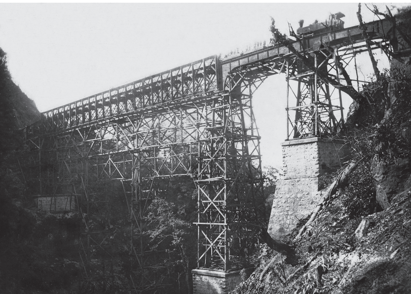
Figura 15: Marc Ferrez, Estrada de Ferro de Paranaguá a Curitiba: viaduto sobre o rio São João k.[m] 62,210 (1884); colódio, p&b (Coleção Thereza Christina Maria, Biblioteca Nacional)
