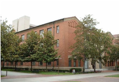
(a) Actual building
