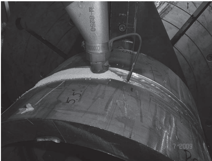
Figura 2. Realização da soldagem de enchimento na tubulação pelo processo SAW.
