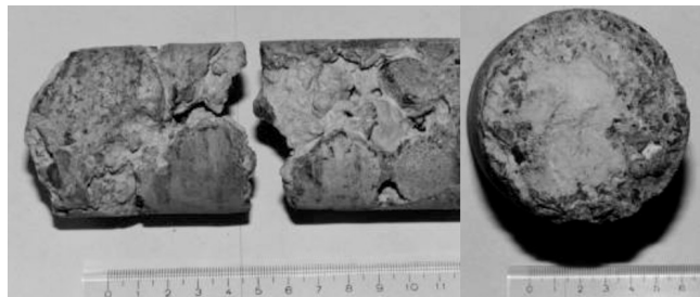
Figure 4: Concrete core samples from the GHPP dam. [Figura 4: Amostras de testemunhos de concreto da barragem Guaricana.]
