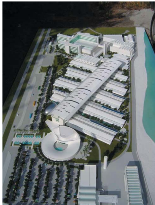
Figura 1 - Vista aérea da ampliação do CENPES, na Ilha do Fundão, Rio de Janeiro.
