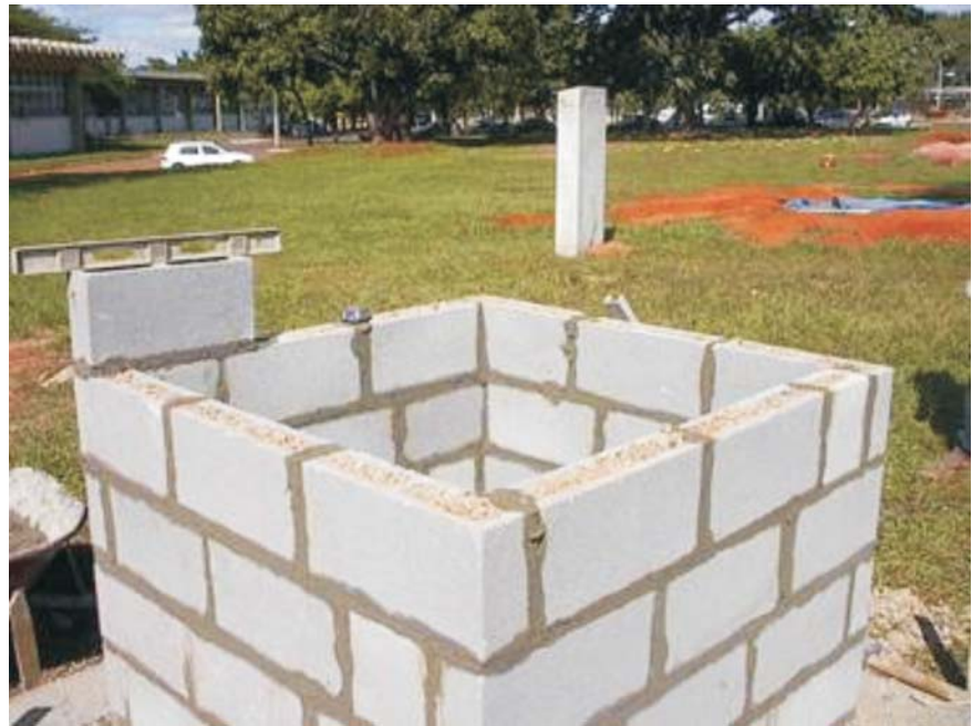
Figura 1 - Test-cell com entulho nos furos dos blocos.
