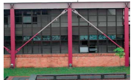
Figura 24 - Repintura em andamento.
