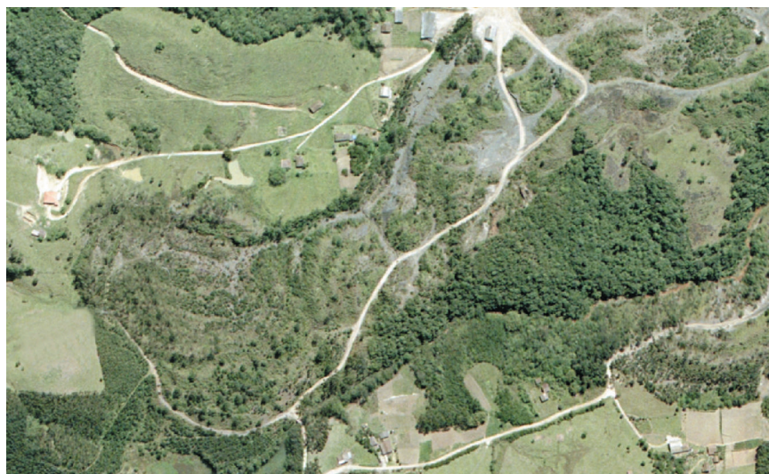
Figura 1 - Aspecto geral do local estudado na localidade de Rio Carvão Alto, município de Urussanga, Santa Catarina.
