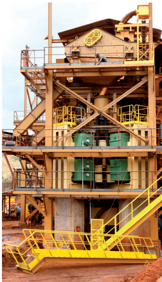
Foto 1 - GX-3600 instalado na Itaminas, Brasil.
