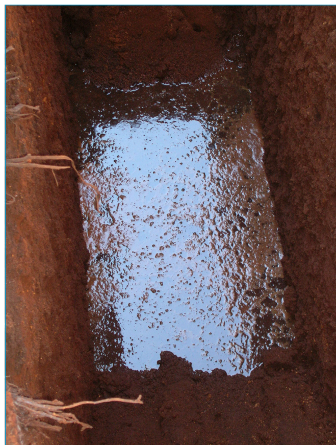
Figura 6 - Escavação com surgimento do lençol freático e pluma de contaminação.
